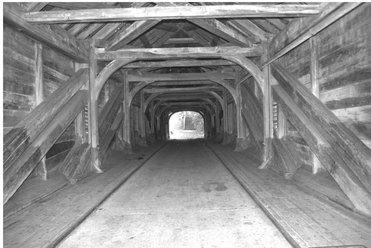
Die Brücke aus dem Jahr 1819. Abb. 1 (PVC, 22. 10. 1992)
