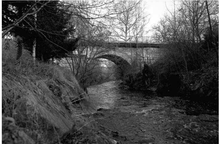
Die Bünzbrücke von 1878 bei Möriken; Blickrichtung Südost. Abb. 1 (do, 11. 3. 1994)
