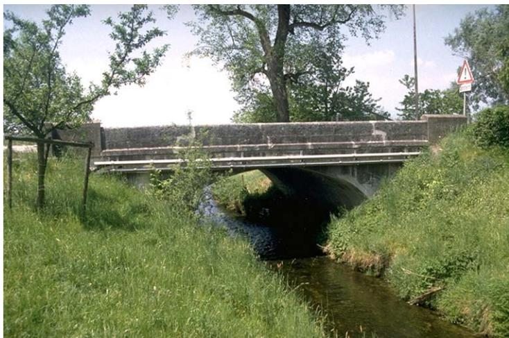
*Einzig die beiden versetzten Brüstungen weisen bei Oeschberg auf die historische Brücke hin. Wegen der Strassenverbreiterung wirken die beiden Fahrbahnbegrenzungen isoliert und dadurch ziemlich unscheinbar. Blickrichtung Nord. Abb. 3 (rb, 14. 5. 1998)*
