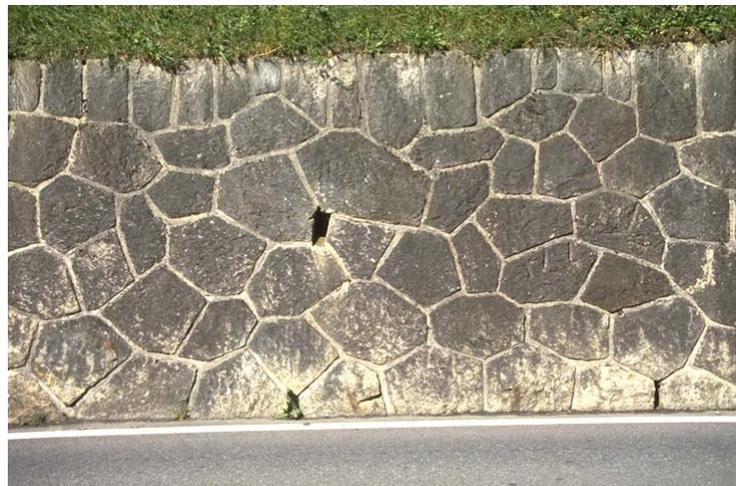
*Die Mauer südlich des Feldmooshubels (Höhe 1630 m) erhält mit ihren wenig bearbeiteten Blendsteinen ein rauheres und dadurch natürlicheres Aussehen. In der durchgehenden Mauerkrone sind Kolonnensteine eingelassen. (Vgl. Abb. 26.)*
