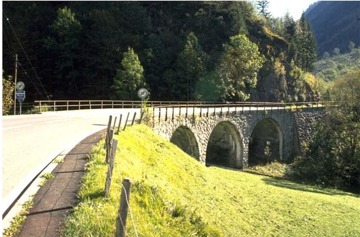
*Bei den Wasserdurchlässen sind die Einläufe zuweilen gemauert, während die Gewölbe unter der Strasse betoniert sind und verblendete Seitenansichten haben. Von der Grösse des Durchlasses her ist die Grenze zwischen einem Tombino und einer Brücke oft fließend. Die Aufnahme zeigt einen Tombino auf dem Löibboden (Höhe 1620 m, vgl. Abb 26).
