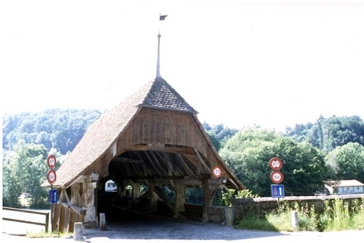
Das Nordportal mit den vorgelagerten Prellsteinen. Abb. 5 (GS, 20. 6. 2001)
