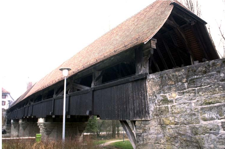
Gesamtansicht der Brücke. Abb. 2 (GS, 15. 3. 2002)
