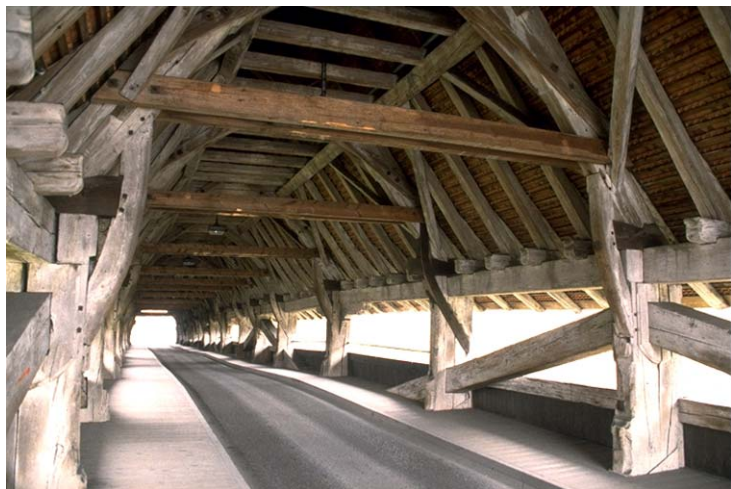
Für den Oberbau der Brücke wurden teilweise massive Balken verwendet. Die Balken der Hängewerke beispielsweise sind 40 cm breit. Abb. 3 (GS, 15. 3. 2001)
