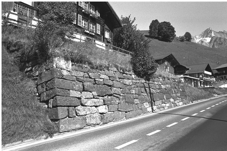
Stützmauer der 1870-90er Strasse im Schlüöcht. Abb. 1 (hrm, 21. 6. 1991)
