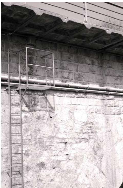
Das mit verputzten Bruchsteinen aufgezogene Mauerwerk im unteren Teil wird von verfugten Bossenquadern überlagert. Deutlich erkennbar sind auch die herausragenden Betonelemente, die als Gehsteige dienen. Abb. 3 (GS, 18. 3. 2006)
