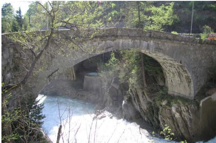
*Der hervorkragende Sims ist eine deutliche Trennlinie zwischen Unter- und Oberbau. Das Bogenwerk wird durch Ankereisen stabilisiert.
