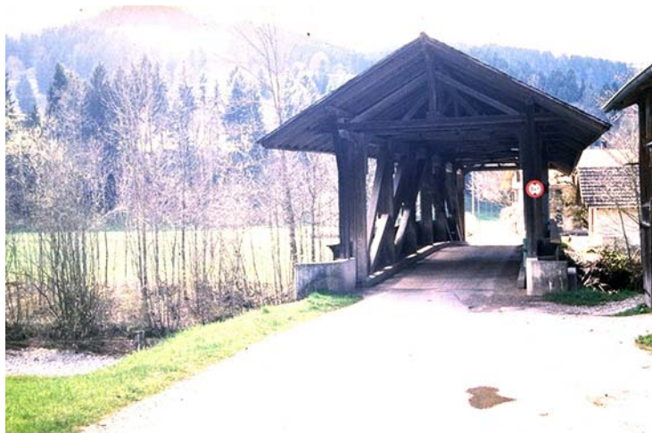
Ansicht der 1887 errichteten Dieboldswilbrücke. Abb. 1 (mf, 1. 4. 2001)
