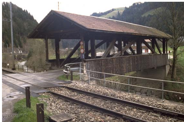
Ansicht der Hängewerk - Steinbachbrücke aus dem Jahr 1891. Abb. 3 (mf, 1. 5. 2001)
