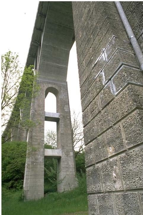
*Unter der Fahrbahnplatte sind deutlich die vier Längsträger und die zusätzlichen Querträger zu sehen.
