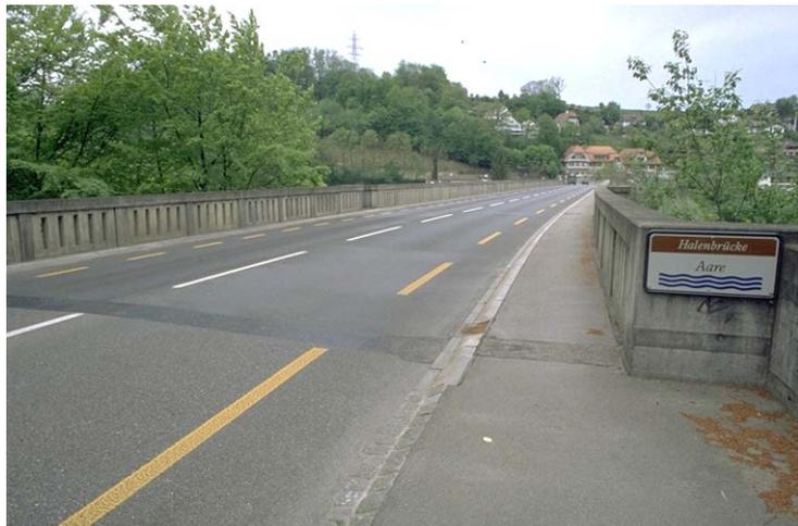
*Die Brüstungen bestehen aus überdeckten Betonplatten, die durchbrochen sind. Im Bild gut erkennbar ist auch die Krümmung des Anschlusswerkes, das zum Hauptbogen führt.
