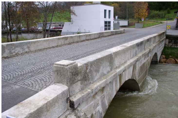
Nach der Restauration: Der Fahrbelag auf der Brücke besteht aus einer Würfelsteinpflasterung im Bogenmuster. Abb. 4 (GS, 27. 10. 2004)
