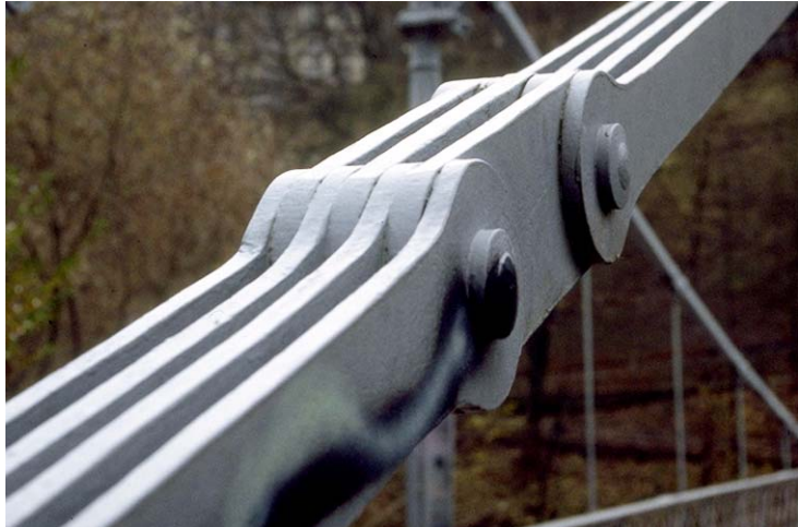
Detailansicht einer Flachkette ... Abb. 2 (GS, 4. 12. 2001)
