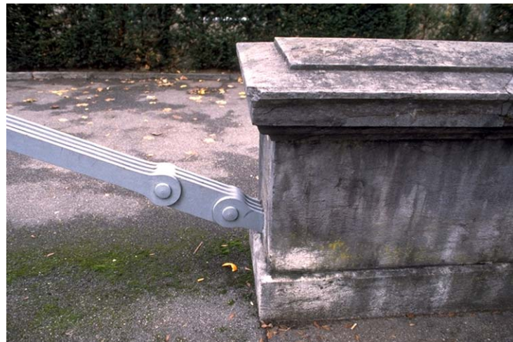
... und der Verankerung am Nordufer. Abb. 3 (GS, 4. 12. 2001)
