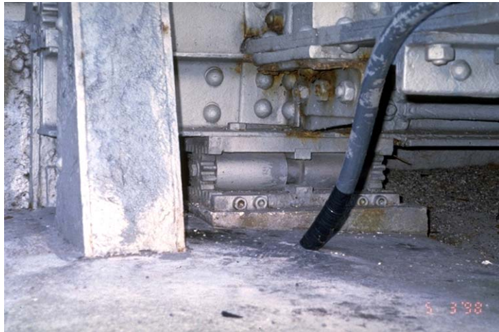
Detailansicht des Rollenlagers am Nordufer. Abb. 4 (do, 5. 3. 1998)
