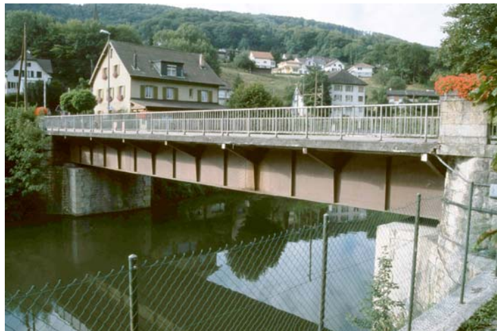
Die 1950 errichtete Birsbrücke von Grellingen. Blickrichtung Süd. Abb. 1 (do, 30. 7. 2003)
