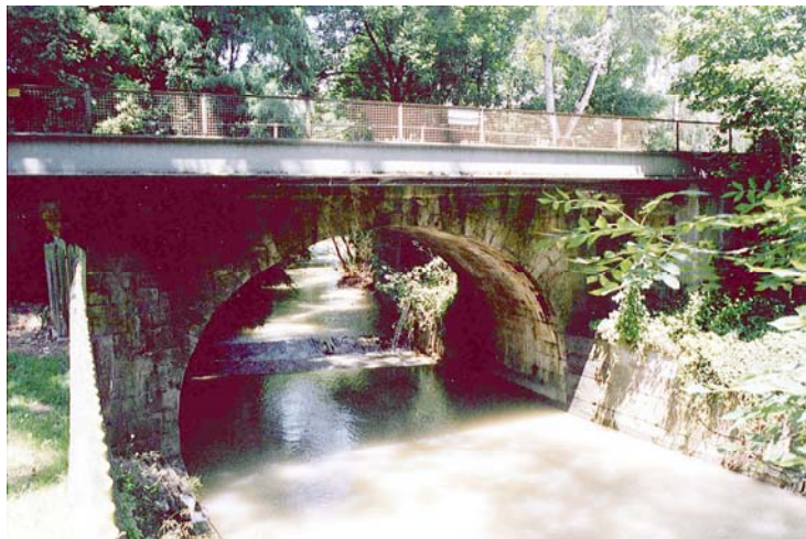
Frontalansicht der Rheinfelderbrücke. Blick bachabwärts. Abb. 6 (D, 2. 7. 1999)
