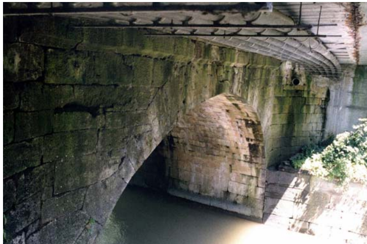
Ostseitige Untersicht und Brückenbogen. Unter der Fussgängerbrücke verlaufen Werkleitungen. Abb. 7 (D, 2. 7. 1999)
