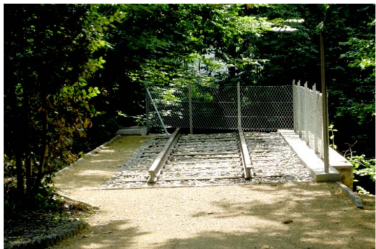
Das museal wiedererstellte Gleisstück der Sissach-Gelterkinden-Bahn. Abb. 3 (D, 18. 6. 2009)
