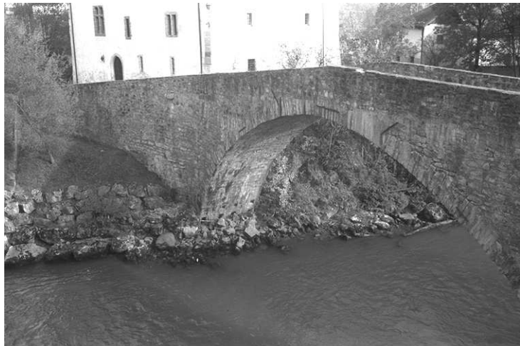
Gesamtansicht der Brücke von Broc, aufgenommen in Richtung der Stadt Greycz. Abb. 2 (JPD, 26. 10. 1989)
