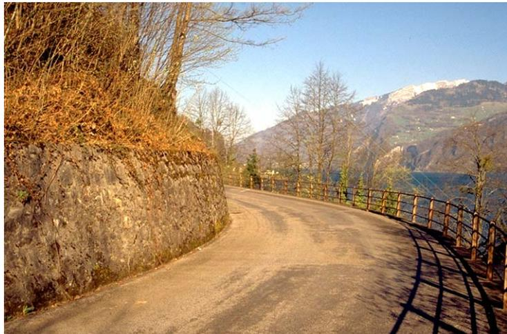
*Im oberen Teil von Mühlehorn wird das Trassee durch Mauern mit integrierten Randsteinreihen gestützt.
