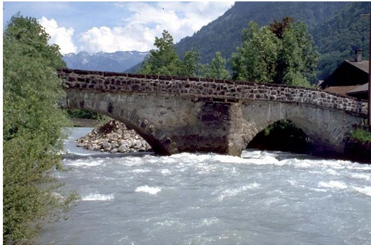
*Der Mittelpfeiler wird oberstrom von einem Wellenbrecher gegen die Fluten der Linth geschützt.
