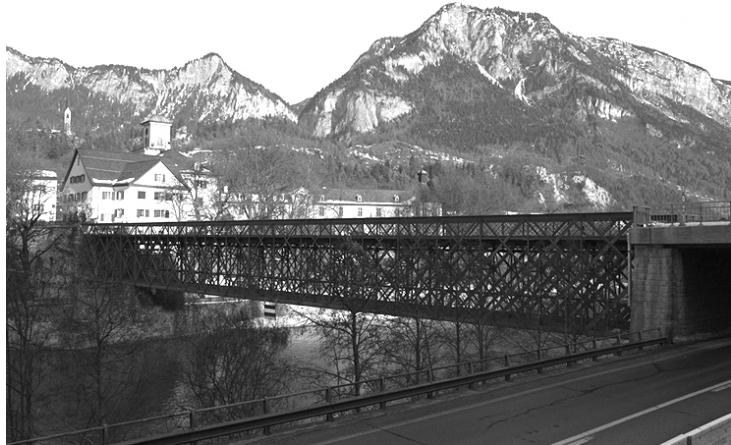
Die Stahlträger-Fachwerkbrücke von Reichenau. Abb. 6 (Heg, 14. 1. 1992)
