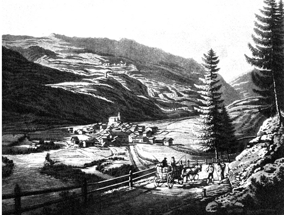
Die neue Kunststrasse von 1818-23 mit Blick auf Andeer und den Schamserberg (MEYER/EBEL 1827: Nr.14). Abb. 1
