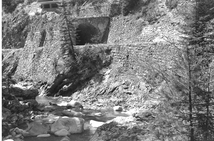
Gemauerte Galerie bei Brombänz. Abb. 3 (Hj, 29. 4. 1994)
