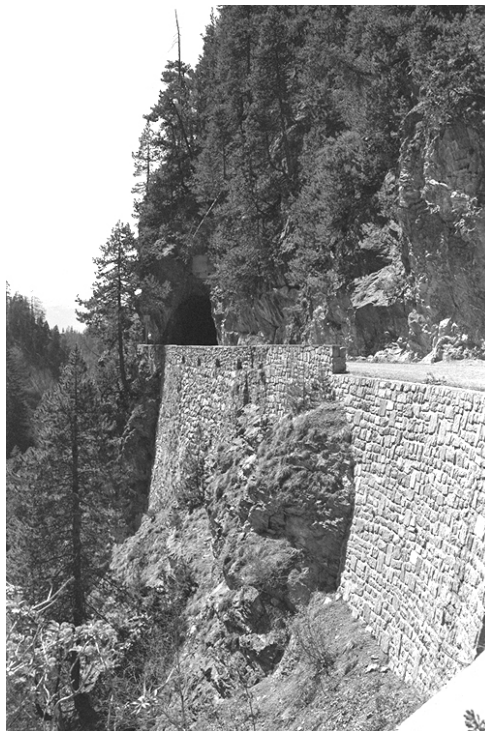
Hohe gemörtelte Stützmauer und Brüstungsmauer im westlichen Teil der Zügenschlucht gegen Wiesen hin. Bergseits ist dieser Teil durchgehend felsig. Abb. 4 (Hj, 29. 4. 1994)
