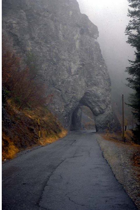
Unverkleideter Tunnel vor dem Versamer Tobel. Abb. 6 (Heg, 10. 12. 1986)
