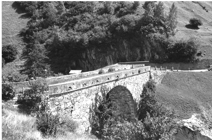
Die gut erhaltene Steinbogenbrücke westlich Sumacla. Abb. 1 (Heg, 22. 8. 1994)
