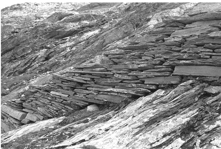
Aus dünnen plattigen Steinen regelmässig geschichtete Stützmauer. Abb. 11 (Heg, 19. 9. 1990)
