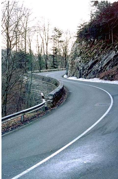
Tracé sinueux entre talus rocheux et murs de soutènements des Malettes à La Malcôte. Fig. 4 (cb, 5. 3. 2003)
