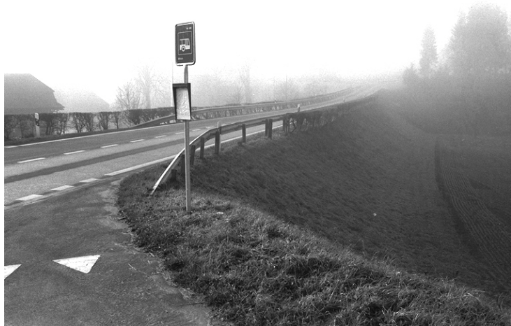
Die Dammaufschüttung... Abb. 1 (mf, 1. 8. 1991)
