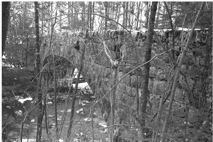
Anblick der flussabwärtigen Fassade vom westlichen Ufer aus betrachtet. Abb. 1 (LA, 1. 3. 1990)
