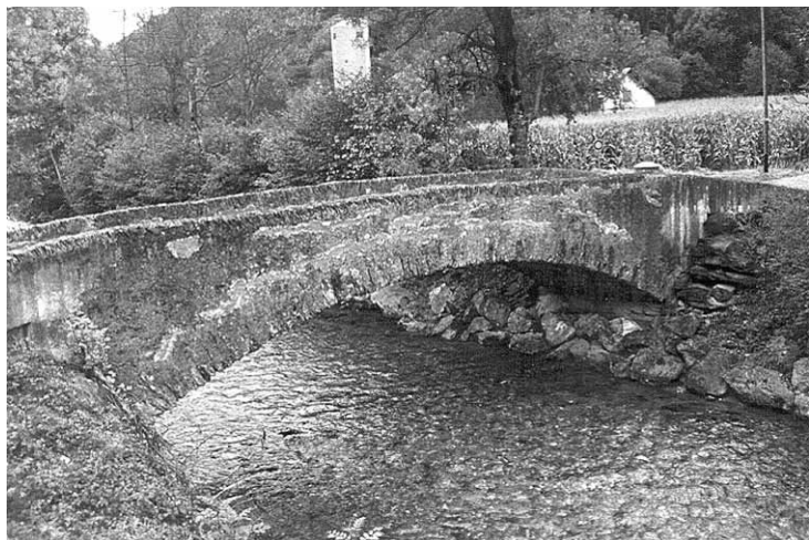
Ansicht der Steinbogenbrücke bei Sax von Osten her. Abb. 1 (ama, 5. 10. 1996)
