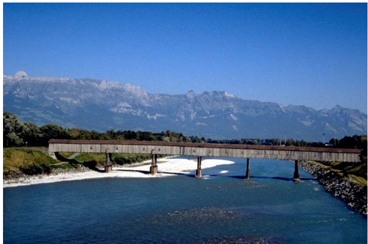
Die Dimension der Brücke wird erst bei Betrachtung aus der Ferne, hier von der 200 m flussaufwärts erstellten Betonbrücke, richtig fassbar. Im Hintergrund die Alpsteinkette. Abb. 3 (ama, 13. 9. 1999)
