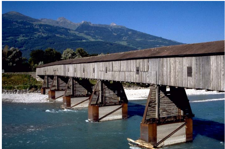
Ansicht der Seveler Brücke mit den fünf Pfahljochen. Abb. 2 (ama, 13. 9. 1999)
