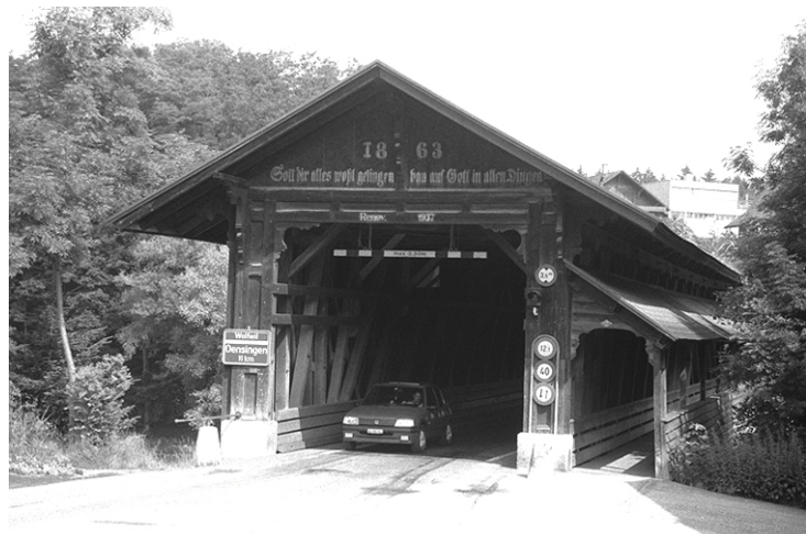
Die 1863 gebaute Holzbrücke über die Aare, von Murgenthal her gesehen. Rechts der 1937 angebaute Fussgängersteg. Abb. 1 (rb, 30. 6. 1992)
