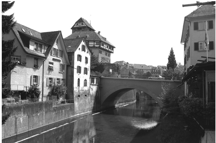
Die Schlossbrücke in Frauenfeld. Deutlich ist die grosse Höhendifferenz von linkem und rechtem Flussufer erkennbar. Abb. 4 (SP, 3. 8. 1994)
