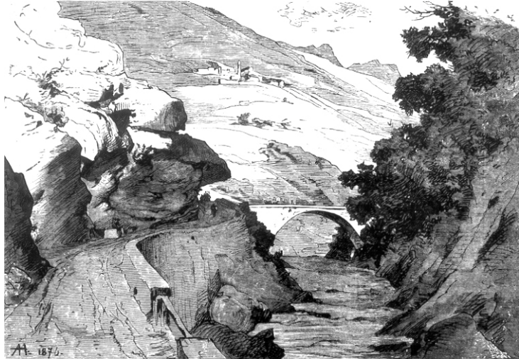
"Ponte di Mezzo" e strada nel 1876 in una silografia di autore ignoto. Dal 1842 i parapetti in muratura sostituiscono quelli precedenti in legno (ACB). Fig. 2
