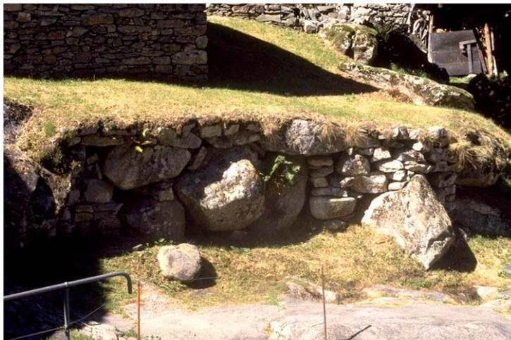
*Il ponte ad arco di Puntid la cui bella struttura è "sporcata" da inutili parapetti in ferro. Si notano al colmo le pietre sporgenti che fungevano da paracarri.*
