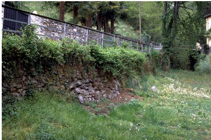
Il muro di sostegno sul lato a valle, in corrispondenza dell'Hotel Belvedere, sormontato da ringhiera in ferro Fig. 2 (CLM, 28. 4. 2003)
