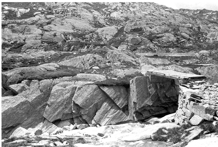
Il ponticello con soletta in cemento attraversa il Reno di Medel nel luogo denominato "alla Presa". Fig. 5 (LIA, 23. 7. 1992)
