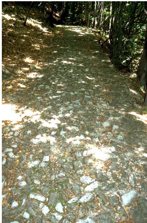
Un ben conservato passaggio selciato lungo la Valle dell'Alpe. Fig. 5 (CLM, 22. 6. 2001)
