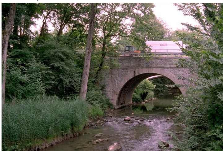
Large pont de pierre à une arche sur la Venoge à la sortie de Saint-Sulpice. Fig. 2 (nab, 1. 6. 2000)
