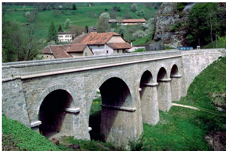
Les Clées: pont à cinq arches de pierre sur l'Orbe Fig. 6 (nab, 3. 3. 2002)
