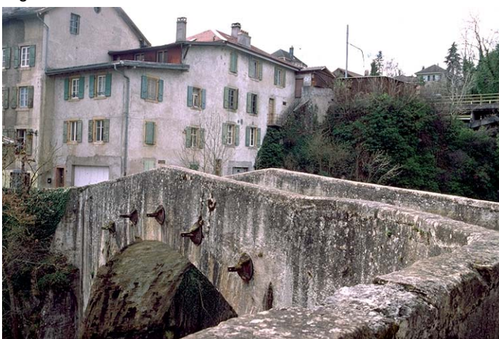
Orbe : pont du Moulinet érigé en 1424 Fig. 2 (nab, 3. 5. 2002)
