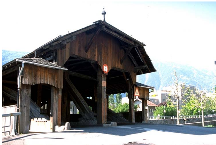
Outre les deux chaussées et les deux passerelles latérales, on distingue la structure en arc du pont de La Bâtiaz. Fig. 6 (BS, 8. 5. 2001)
