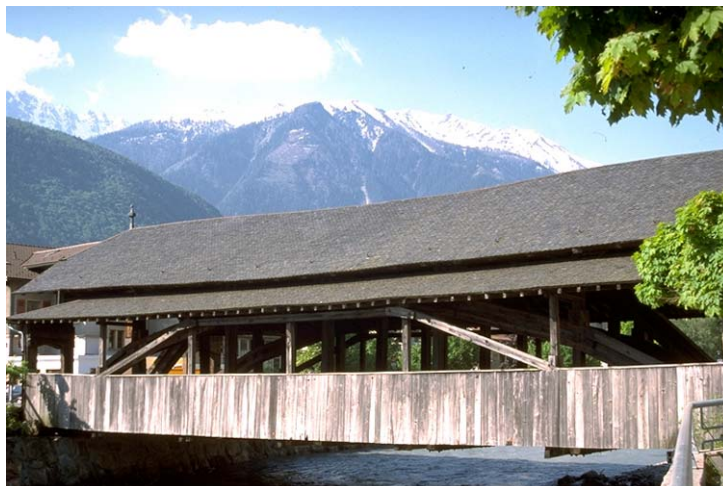
Vue latérale du pont couvert de La Bâtiaz depuis le nord-est Fig. 5 (BS, 8. 5. 2001)
