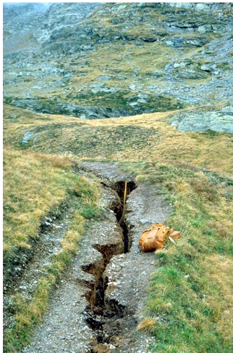
Das Ausheben eines Fussweges durch einen Kleinbagger ohne sorgfältige Entwässerung des Weges bewirkt im Wegbett rasch eine Tiefenerosion im Lockermaterial. Beispiel auf der Distelalp auf einer Höhe von 2250 m. Abb. 13 (Ae, 29. 9. 1999)
