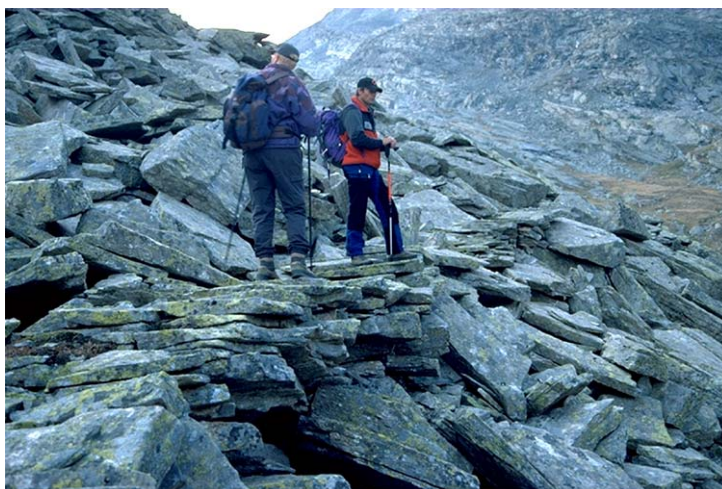
Treppenartiges Wegpflaster auf der Höhe von 2350 m. Abb. 6 (Ae, 23. 9. 1998)
