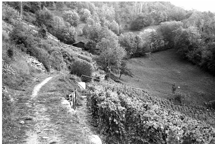
Passage durch die Rebberge bei Chalchofe. Die stellenweise eingefallenen Trockenmauern werden im Rahmen des Wiederherstellungsprojektes erneuert. Blickrichtung nach Osten. Abb. 8 (RF, 11. 10. 1993)
