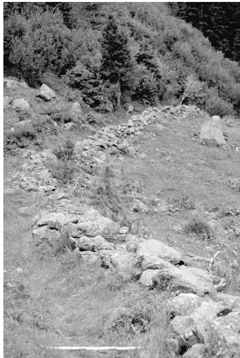
*Detail aus der zweihäuptigen Steinlesemauer bei Zer Tänt. Die Mauer ist 1 m breit und zwischen den Aussenmauern lose mit Lesesteinen aufgefüllt.*
