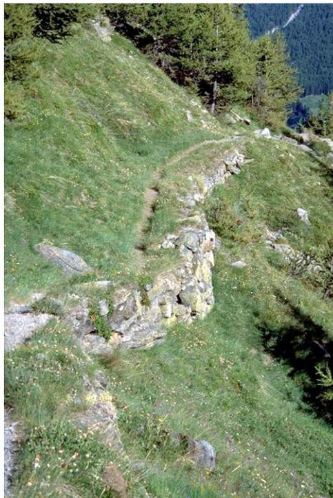
*Die Mauer oberhalb von Jungu auf 2080 m trennte nach 1930 die Weiden (rechts) und die Aufforstungsflächen. Die 2 m hohe Trockenmauer wurde mit einer überkragende Mauerkrone zum Schutz der Jungpflanzen gegen Geissen abgedeckt. Um den im Sommer 2001 ausgehobenen Erdweg in den bisherigen Weg einzuleiten, wurde in die Grenzmauer eine Bresche gebrochen.
