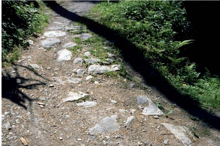
Vestige de pavage dans le virage 34. Fig. 4 (BS, 14. 6. 2001)
