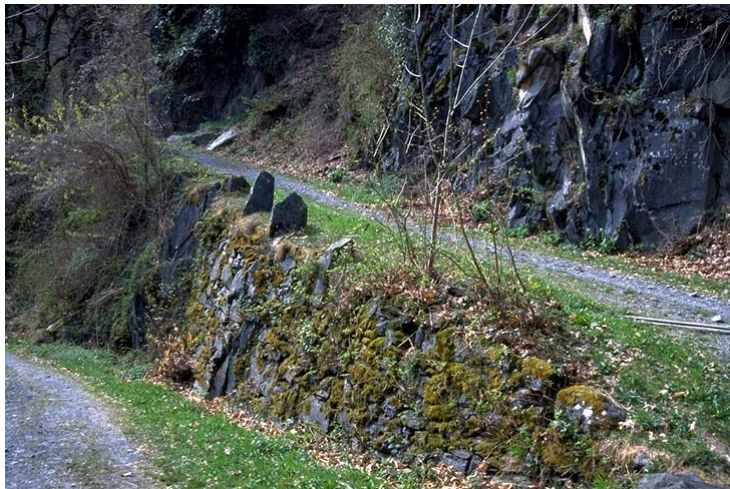
Mur de soutènement au milieu d'un virage (1) surmonté de pierres bordières enchassées dans son couronnement et paroi rocheuse bordant la route des diligences à l'amont. Fig. 5 (BS, 8. 5. 2000)
