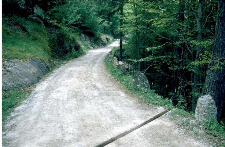
Le virage 2 est aménagé à l'intérieur du pont du chemin de fer construit en moellons, et est taillé dans le rocher. Le virage 3 surplombe le précipice, délimité par une barrière de bois du côté aval. Le virage 10 présente la particularité d'être précédé par une chaussée, bordée de deux murs de soutènement en pierre sèche traversée par un tombino.
