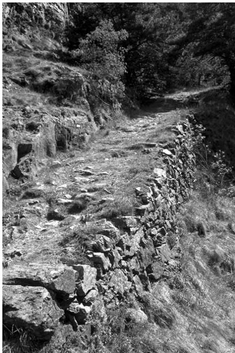
Du côté amont, le chemin côtoie la paroi rocheuse qui a souvent dû être taillée. Aux endroits particulièrement exposés, entre le 2ème et le 3ème lacets et aux abords du 10ème, un parapet surmonté d'une barrière métallique borde le chemin à l'aval.
