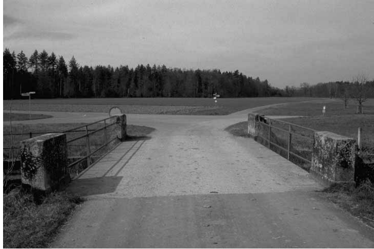
Die Brücke bei Frauental, welche von der Klosteranlage zur Strasse hinführt. Abb. 1 (hus, 28. 3. 1998)
